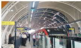
Stasiun LRT Harjamukti
