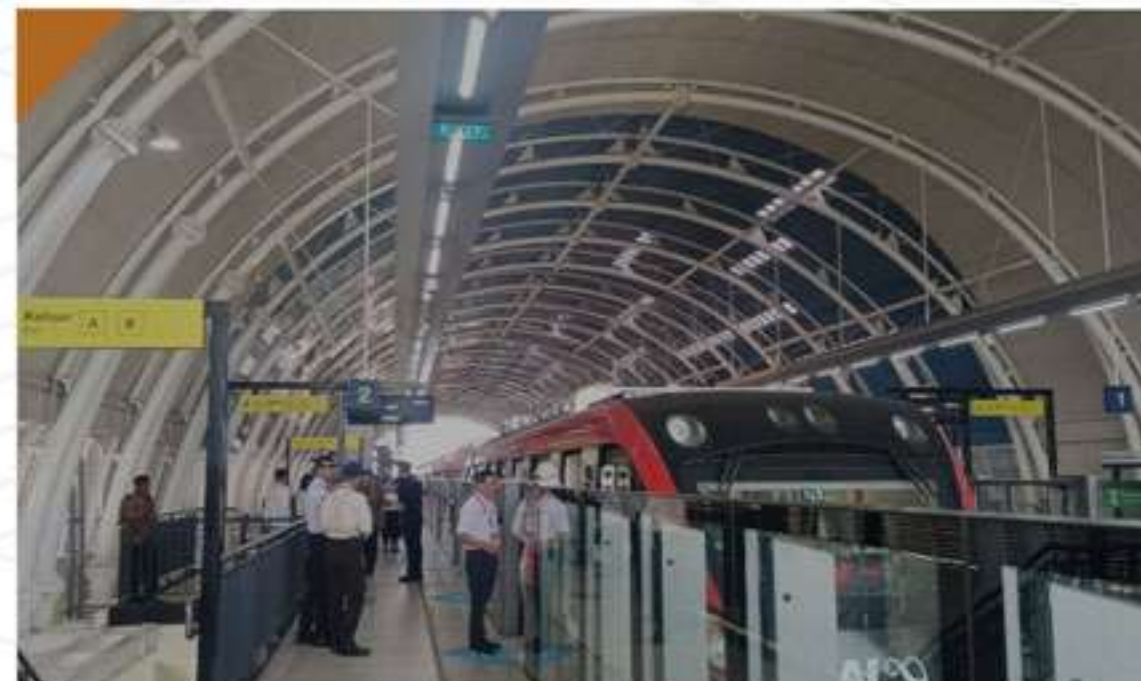
Stasiun LRT Harjamukti
